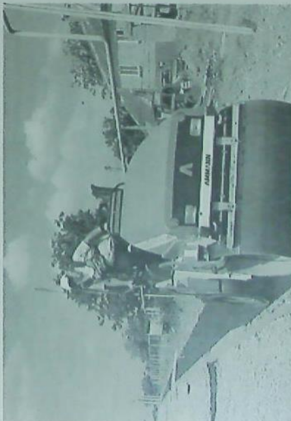
► А вот и последние штрихи: каток утрамбовывает свежий асфальт.
