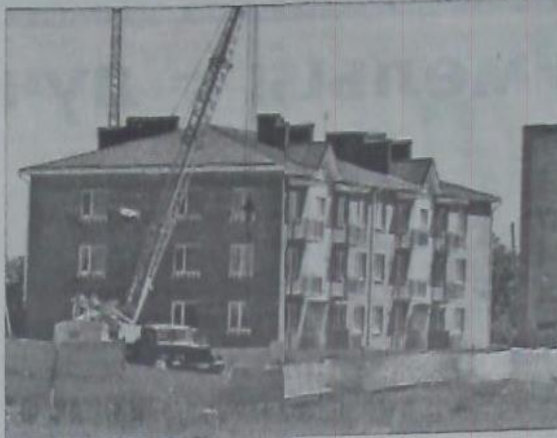
◆ Завершающий этап строительства 24-квартирного жилого дома, который был сдан в эксплуатацию в декабре 2012 года.
